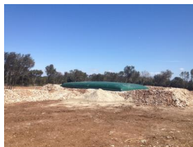
Réserve de 120 m 3 d'eau pour la lutte contre l'incendie sur l'emprise du projet
